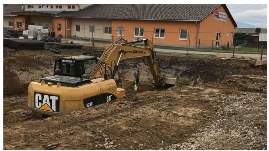
Am Anfang aller Neubauprojekte steht der Aushub. Dabei wird Erdreich ausgehoben und eine Baugrube entsteht. Der Aushub der Baugrube ist die Voraussetzung um Fundamente und Unterkonstruktionen einsetzen zu können.
